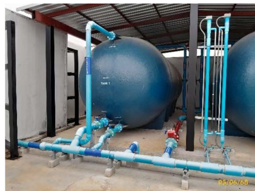
ระบบน้ำสำรองดับเพลิง (ควดฟ้า)
